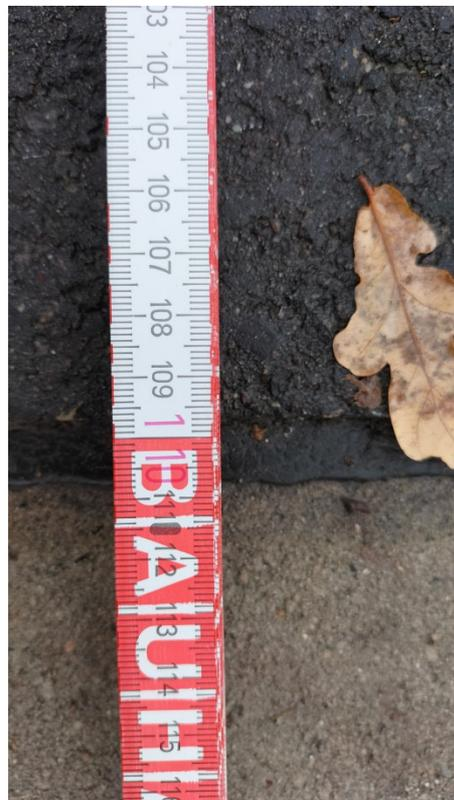
Die Rotmarkierung des Schutzstreifens an einer Einmündung zeigt sogar lediglich 100cm Breite:
