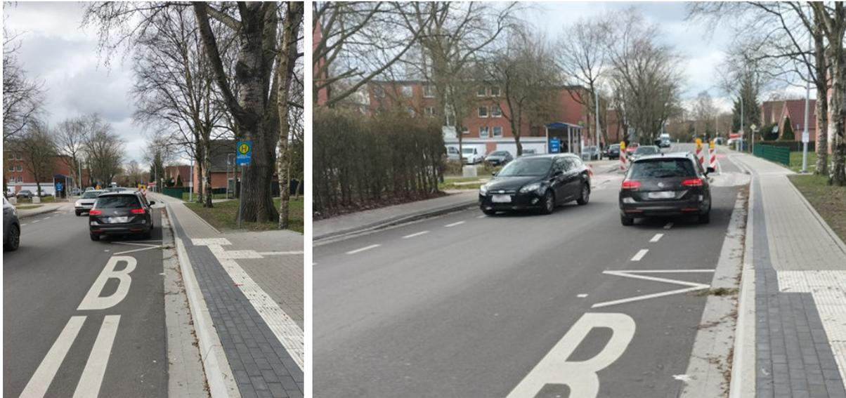
Ein weiterer Schwachpunkt des Schutzstreifens ist seine **zu geringe Breite**. Diese beträgt von der gestrichelten Linie bis zum Anfang des grauen Rinnsteins **gerade mal 110cm**.
