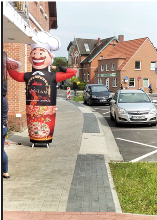
Blockierter Gehweg Fockenbollwerkstraße
