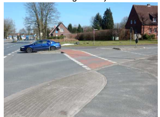
Abgesetzte Radverkehrsfurt (Esenser Straße/Skagerrakstraße)
