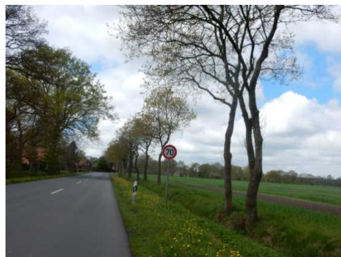
Fehlende Radverkehrsanlage außerorts (Spekendorfer Str.)
