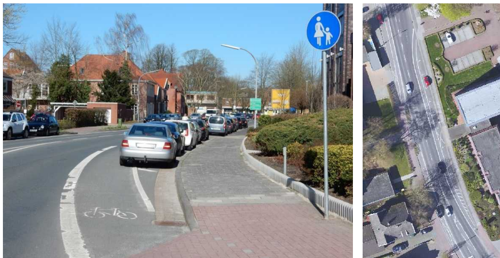
Abb. 55 Radfahrstreifen in der Julianenburger Straße
