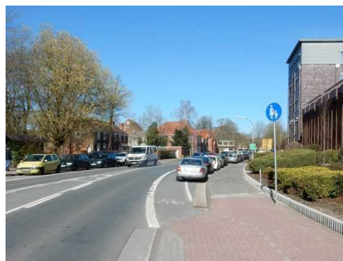
Radfahrstreifen (1,40 m) – fehl. Trennstreifen (Jul.-burger Str.)
