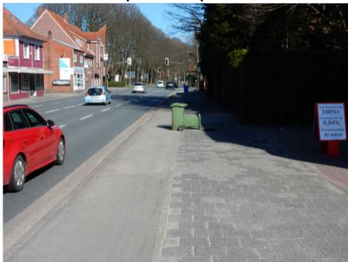
Eingeschränkte nutzbare Breite des Radweges (Esenser Straße)
