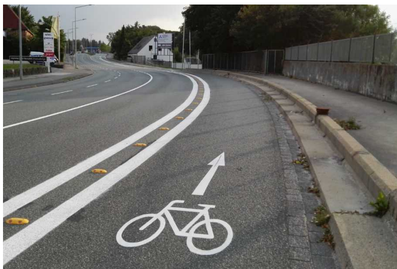
Abb. 63 Beispiel einer Protected Bike Lane in Flensburg
