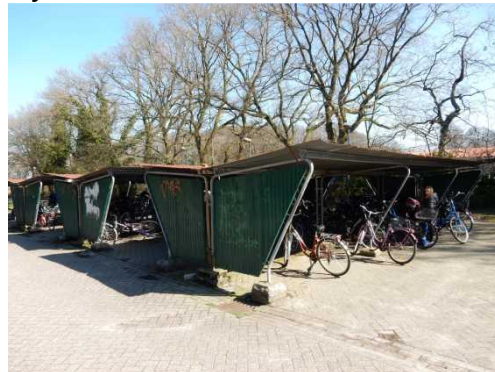
Überdachte Abstellanlagen an der IGS Aurich-West
