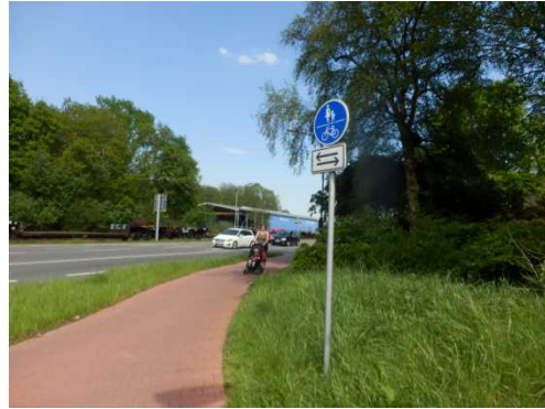
Zweirichtungsradweg innerorts (Emder Straße)
