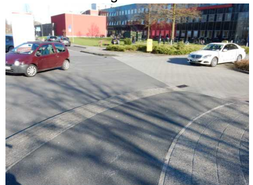
Radweg endet ohne Hinweisschild (Wallinghausener Str.)
